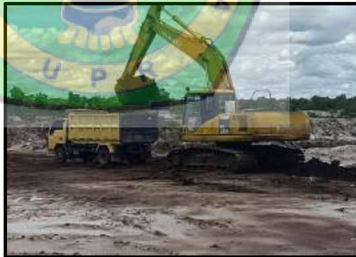
Gambar 4.1 Proses Loading Excavator Komatsu PC 200 dengan Dump Truck 120 PS
